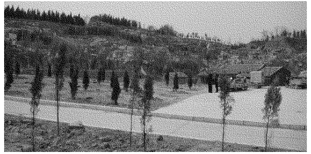
图 3 治理后的边坡(局部)
