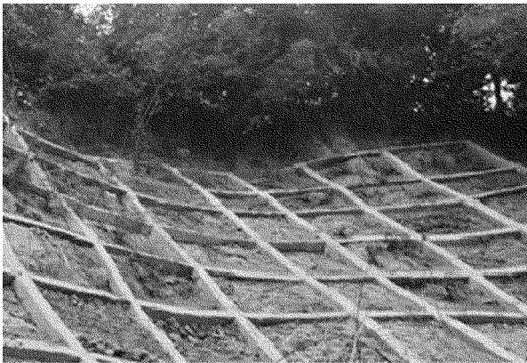
图 2 混凝土格构护坡
