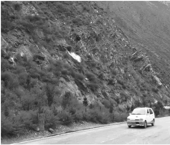
图 3 K64+150 处崩塌侧面
