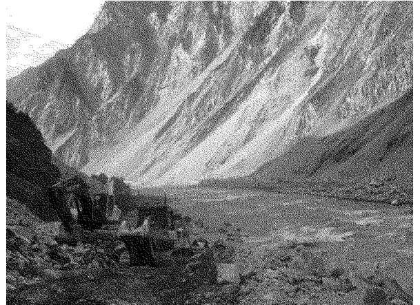
图2 岷江两岸公路崩塌滑坡
