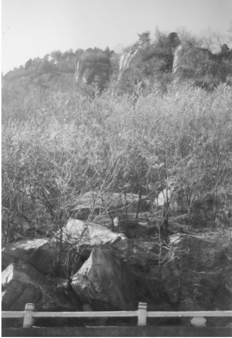
图 2 马蹄峪崩塌(下部为崩塌物)
